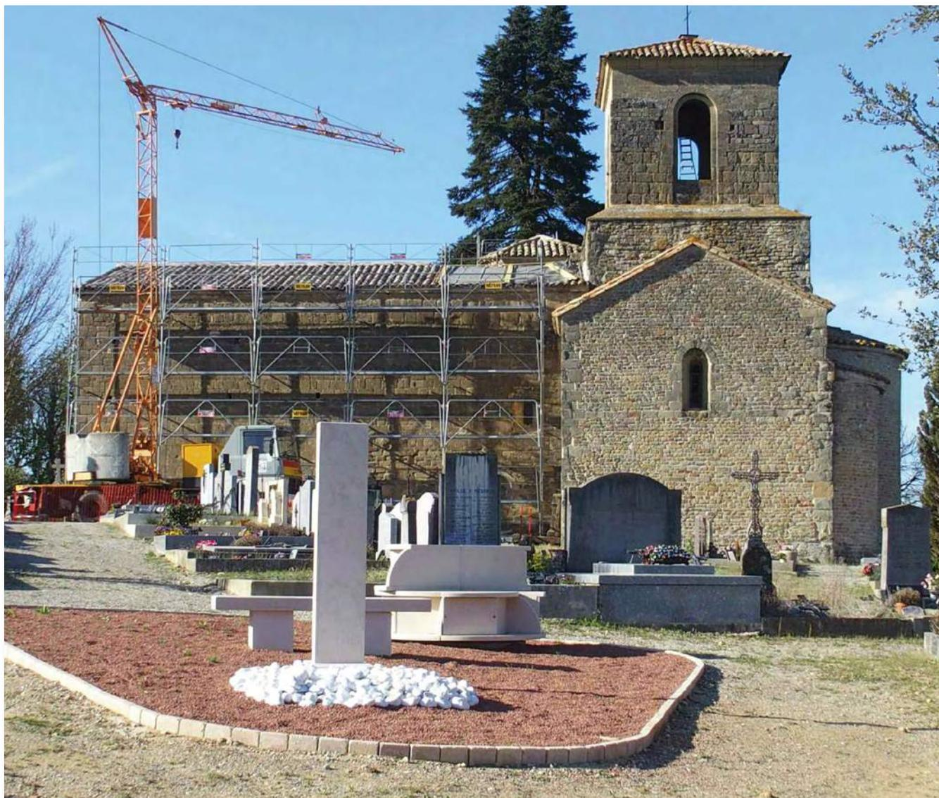
Au mois de mars, pendant plusieurs semaines, la chapelle s'est habillée d'un impressionnant échafaudage. L'entreprise Gerbout (CBGP) de Bourg de Péage intervenait sur l'ensemble des toitures pour la réparation des dégâts causés par la grêle.
