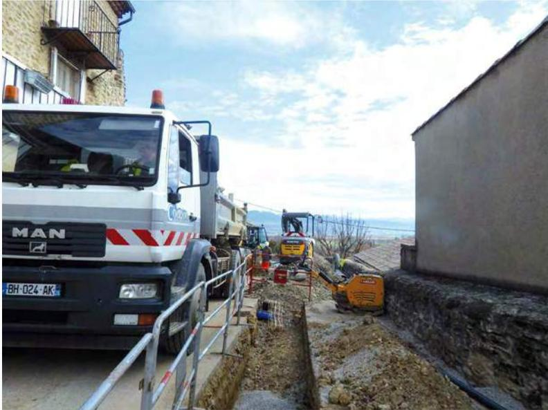
Les travaux de mise en séparatif du réseau d'assainissement et de renforcement du réseau d'eau potable sont arrivés à leur terme.
